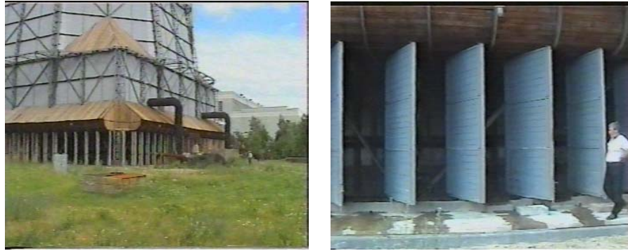
а б Рис. 3. Внешний вид модернизированной градирни № 1 Гродненской ТЭЦ-2, имеющей в основании квадратную форму (а), с встроенным аэродинамическим завихрителем по периметру воздухоподводящих окон (б)
